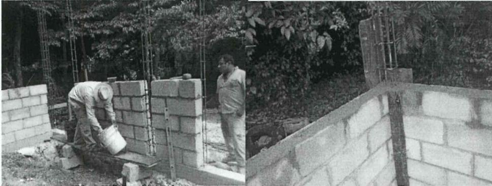
Armado y colocación de acero en el block U, para fundir la solera intermedia, así mismo se han fundido los troncos de columna.
